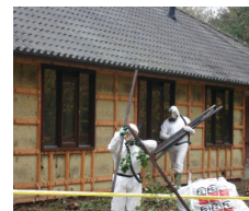
Asbestsanering
